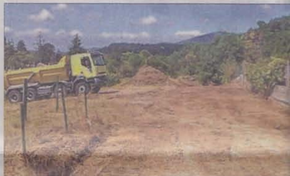
L'arrivée des premiers engins sur le chantier.
